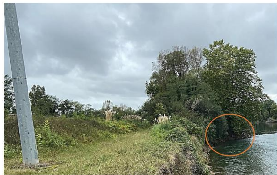
Figure 10 : Épis au pk 10 - rive gauche
